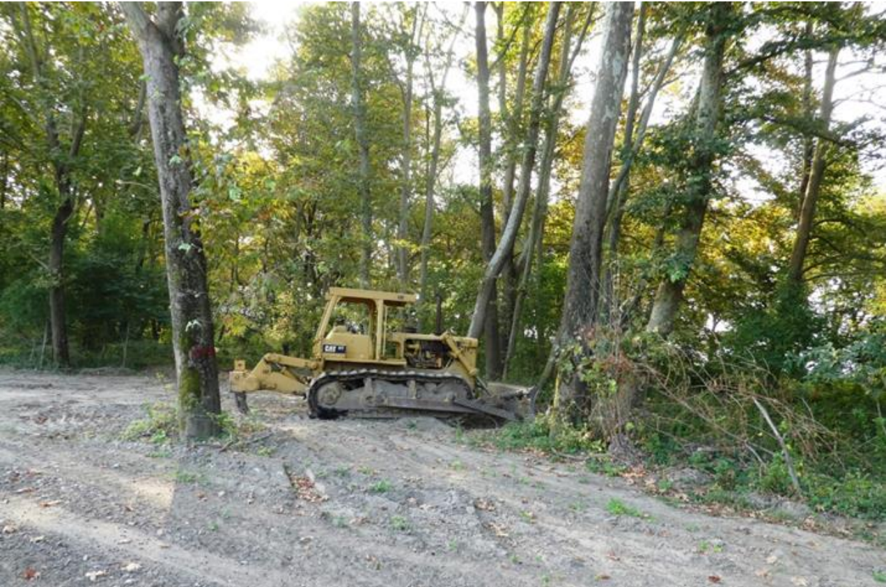
Εικόνα 5. Το παθογόνο διαδίδεται με μηχανήματα εκσκαφής που πληγώνουν τις ρίζες και τον κορμό των δένδρων πλατάνου.
