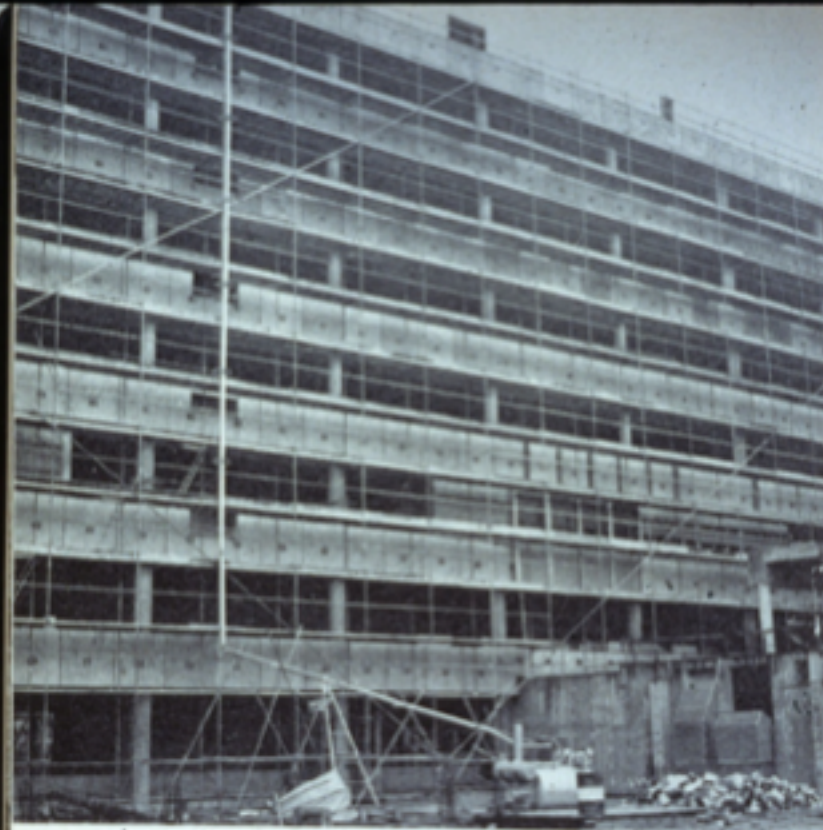
Bild 18: Förderung der heißen Bitumen- Klebmasse zur Verwendungs- stelle mittels Bitumenpump- kocher.
